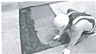
ゴムラテモルタルの施工状況
