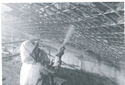
NEXSUSの施工状況 (吹付工法)
